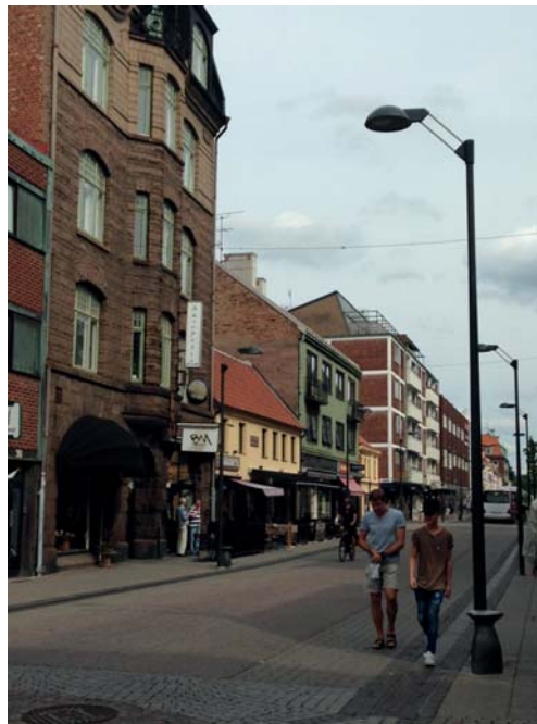
Befintlig fasad mot Brogatan.
