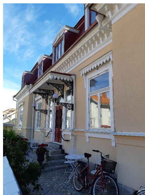
Bild 20: Bilden visar hur Borgmästarvillans takfot möter fasad med stor detaljrikedom, fönstrens omfattningar med vackra överstycken samt entrépartiets genomarbetade utformning. Fasadens är uppdelad horisontellt med profilerat listverk, så kallad gesims (Emma Nordebo Snygg 2022).
