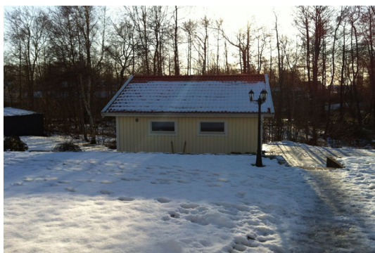
Garage på fastigheten Spekedal 1:127
