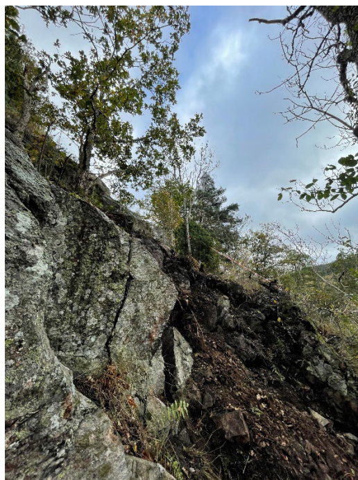
Figur 10 Observationspunkt 28 efter skrotning av blocket utförts.
