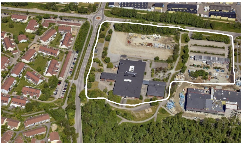
Bild 1. Vy över Håstensskolan (del av Getakärr 2:21) med omnejd. Den vita markeringen anger den yta som berörs av ändringen.
