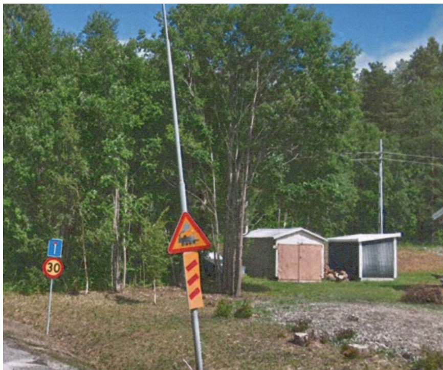
Befintliga förråd som avses rivas och nytt uppföras. Foto tagit från Elsavägen i korsningen mot Hampnäsvegen. (Källa: Örnsköldsviks kommun).
