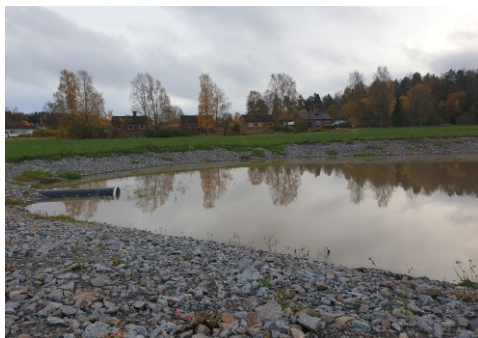
Dagvattendamm utanför planområdet
