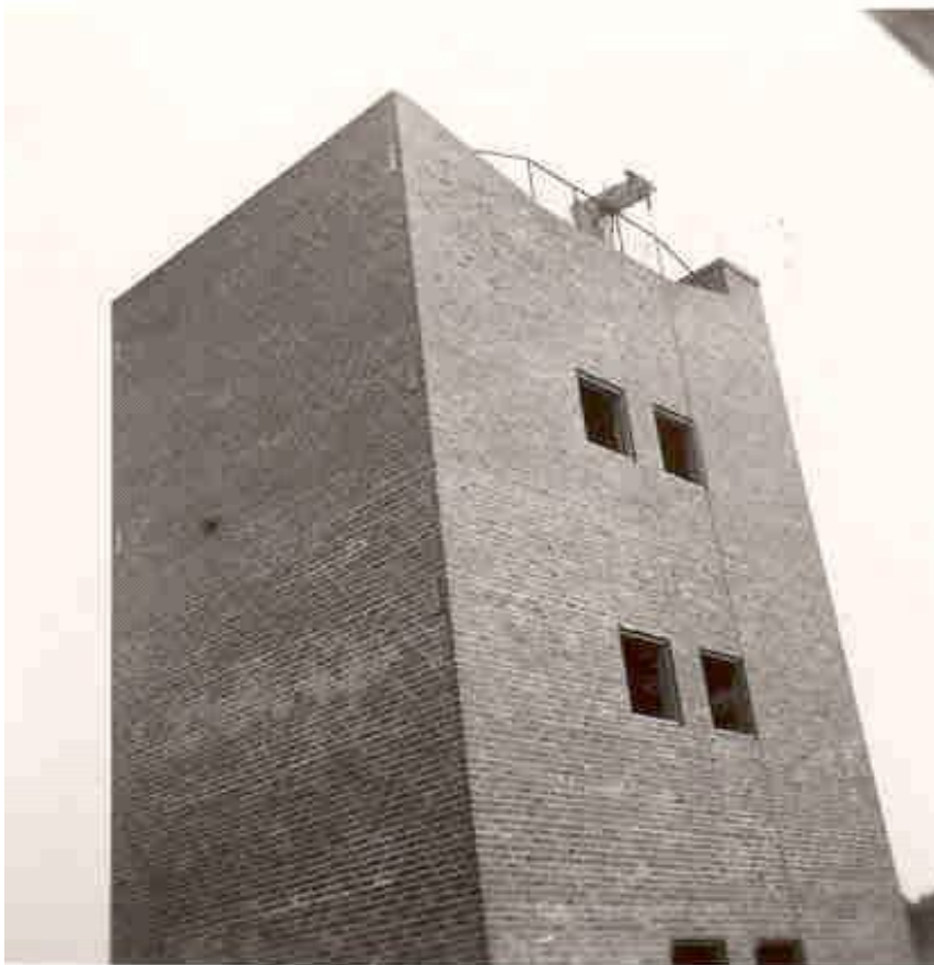
Silon under uppbyggnad, 1955
