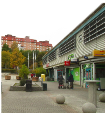
Parkeringshus med lokaler mot centrumstråket
