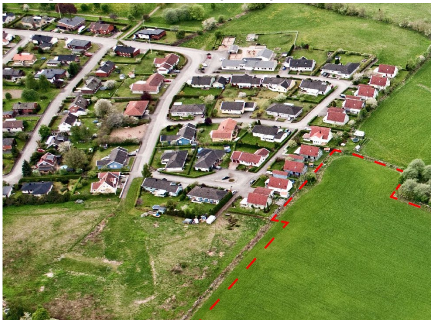
Figur 8 visar det befintliga bostadsområdet från nordost.
