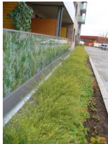
Exempel på hur en torr översvämningsyta kan utformas och rain garden (Källa: Norconsult)
