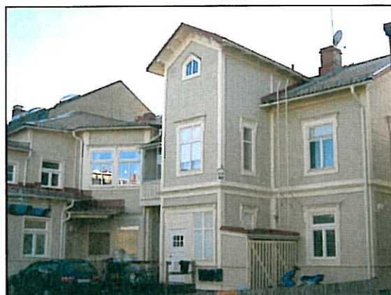
Fasad mot innergården
