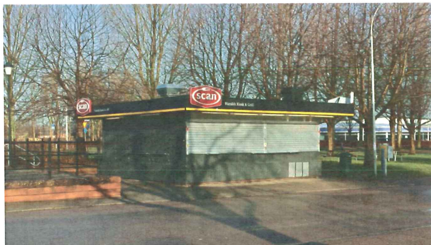
Haralds kiosk och grill sett från söder.
