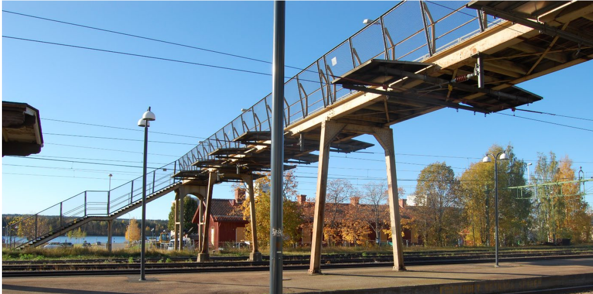
Den nitade gångbron över järnvägen från 1935.
