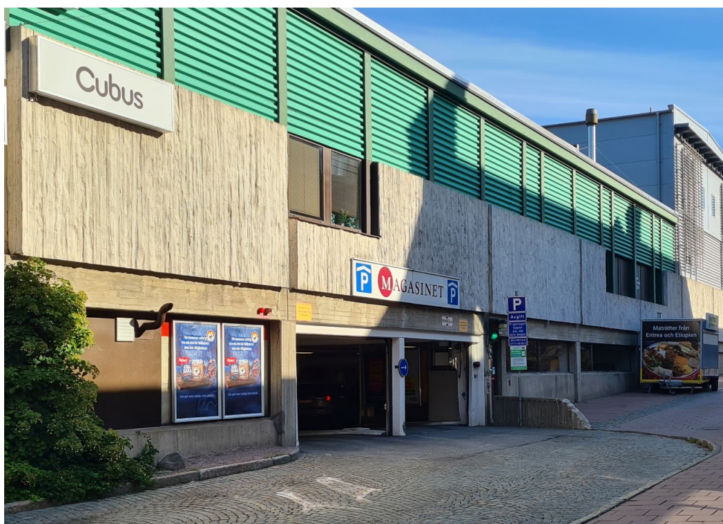
Fasad mot Torggatan med betongelement ovan sockelvåning.
