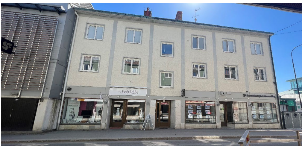
Vy mot byggnad längs Skolgatan som bedöms ha ett kulturhistoriskt värde inom planområdet. I bilden syns den putsade fasaden som är indelad i sex fält.
