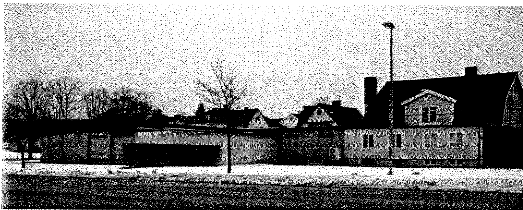
Befintlig bebyggelse på Åldermannen 1, möbelaaffär med boningshus sett från söder.
