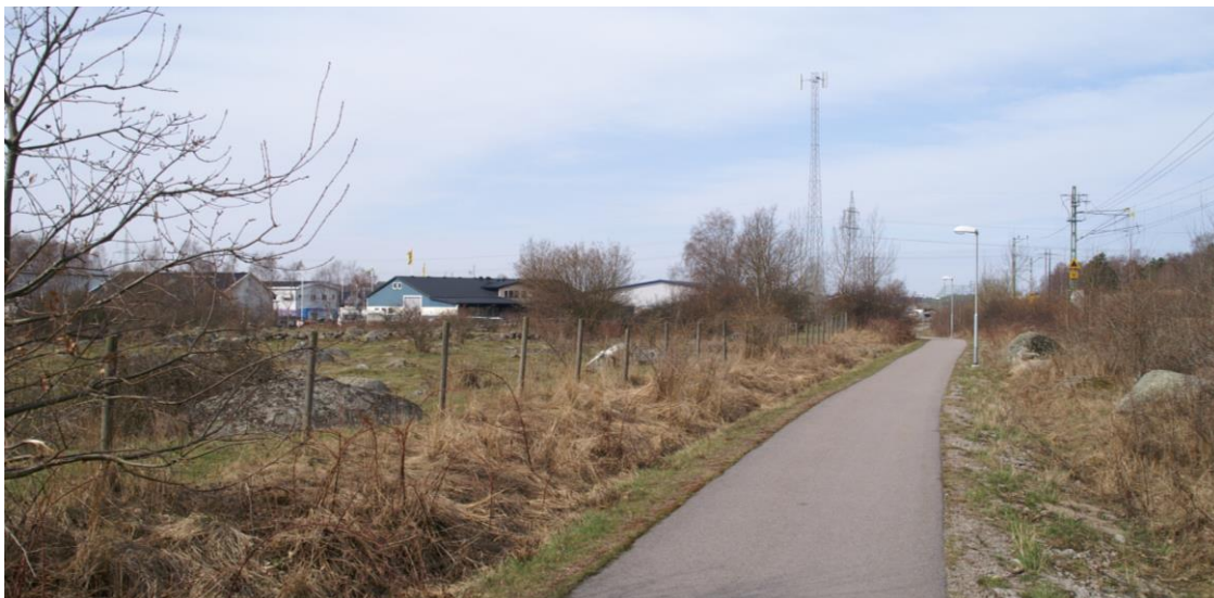
Befintlig GC-väg utmed järnvägen Kristianstad - Karlskrona
