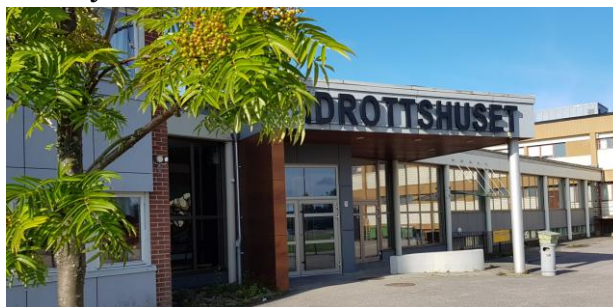
Entrén till Idrottshuset. Positivt exempel med flera detaljer av punkterna nere.
