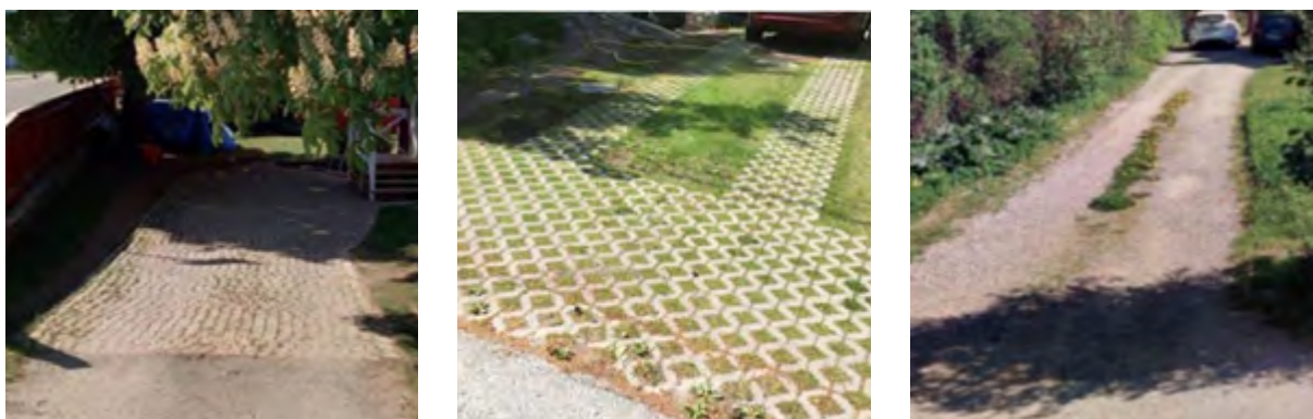
Figur 8: Exempel från Järfälla på genomsläpplig markbeläggning för biluppställning på kvartermark
