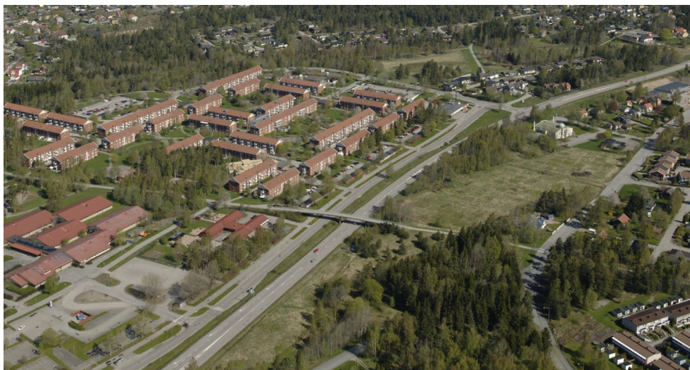
Väg 45 genom Sylte samt skogspartiet i anslutning till Syltebron och Lextorpsvägen
