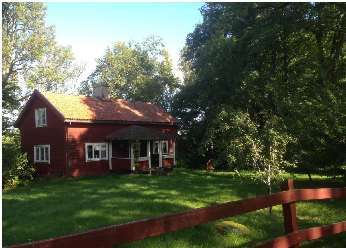
Bild 8. Det befintliga bostadshuset på Rydsnäs 1:87
