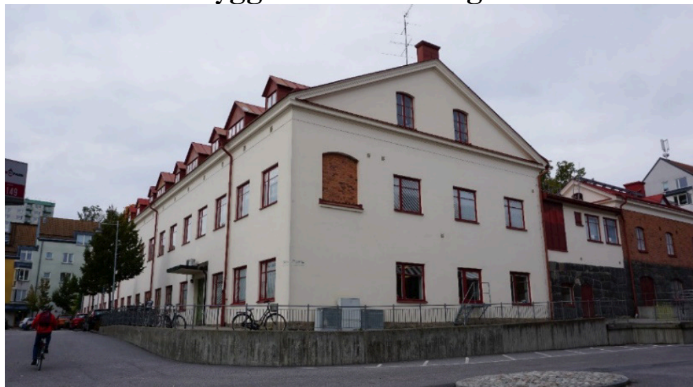
Byggnaden med vy från sydost. Den igsatta fönsteröppningen visar de ursprungliga fönsterformerna.
