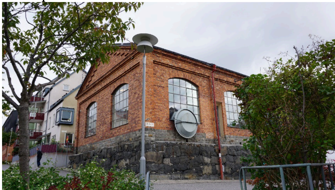
Pumpprovningen, byggnadens västergavel och del av södra fasaden med den tunga stensockeln och rusningstrumman i fönstret.
