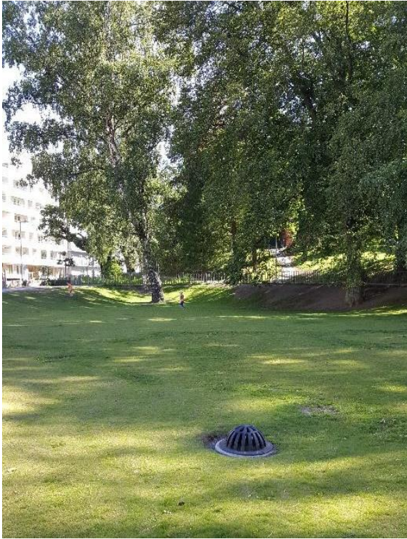
Figur 8. Torrdamm i parkmiljö.
