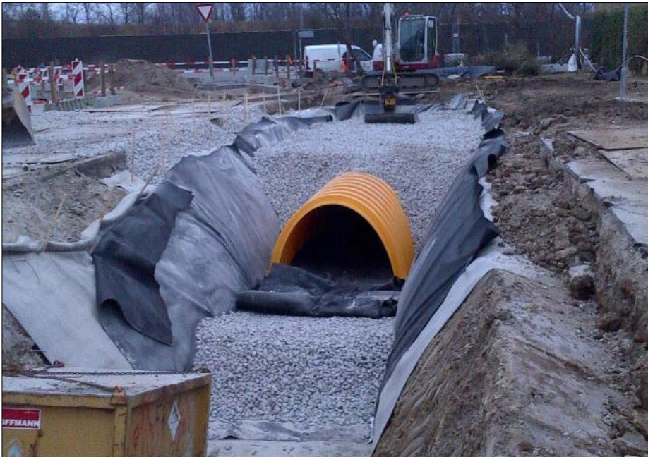
Figur 14. Anläggning av ett tunnelmagasin. Bilden tillhör Milford
