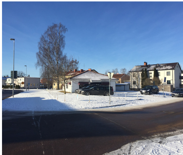
Befintlig byggnad inom aktuellt område (sydöstra riktningen)
