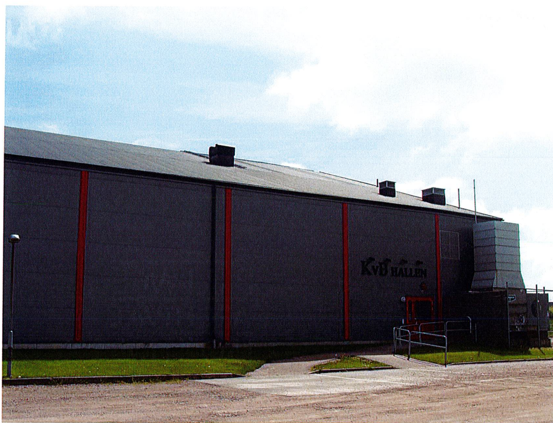
Planområdet med befintlig ishall, sett från väst.
