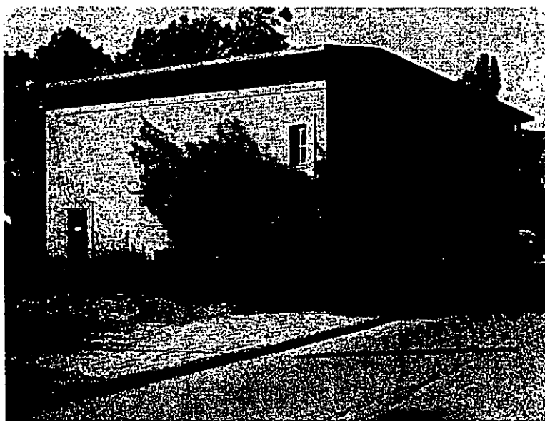
Ställverksbyggnaden vid Polhemsgatan (Foto: Stefan Modig)
