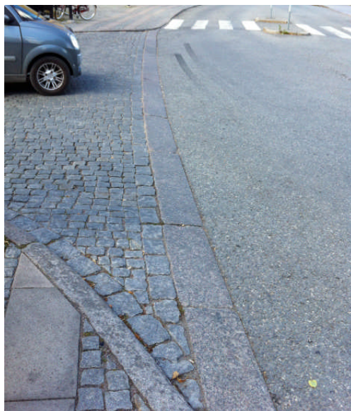
Exempel på hur markbeläggning tydliggör gräns mellan olika körbanor.
