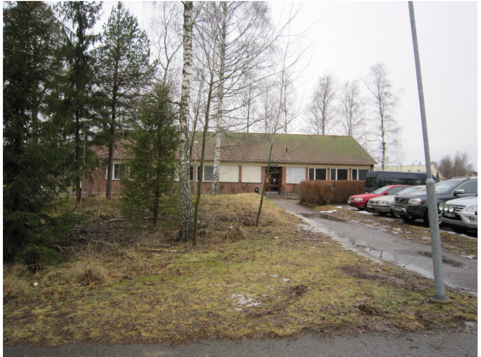
Befintlig byggnad med parkeringsplatser norr om planområdet
