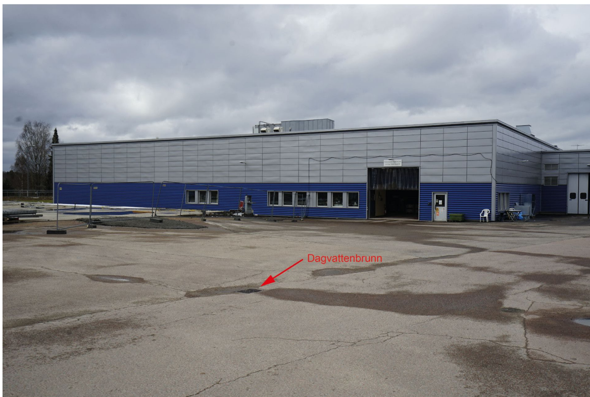
Dagvattenbrunn i vändplatsen av Fabriksvägen
