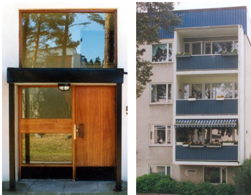
Figur 7 & 8: Fotografier från Kv. Vetterstorp 1-4 ur Det byggda kulturarvet.
