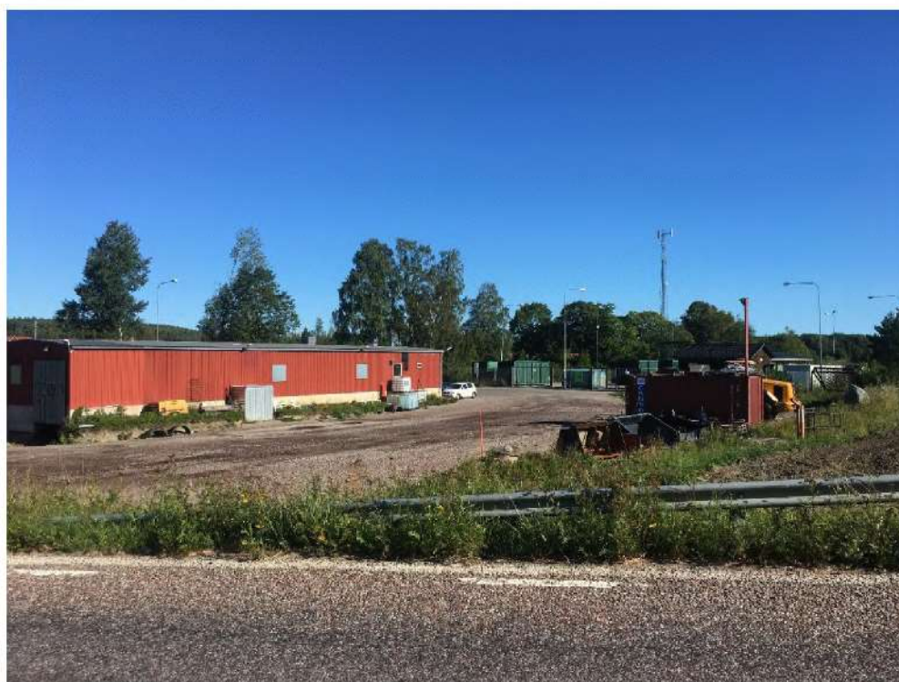
Gamla reningsverket sett från Gammelstillavägen.
