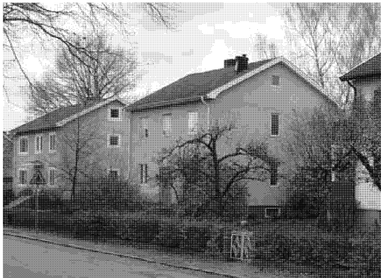
Getskäret 7 och 8 är goda tidstypiska exempel på byggnader med värdefull exteriör som ingår i den kulturhistoriskt intressanta bebyggelsemiljön i Tingvalla.
