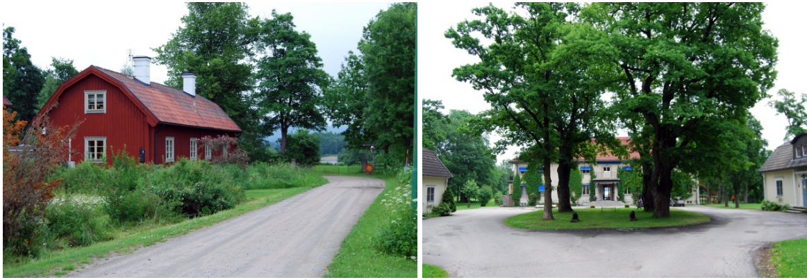
En av de gamla arbetarbostäderna från brukssamhället utmed Bruksgatan (t.v.) och entrén till Kilaforsherrgård (t.h.). Foto Vectura.
