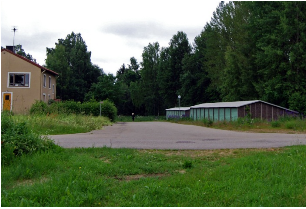
Polgatans förlängning ansluter till befintlig korsning vid Bruksgatan/Smedjegatan. Foto: Vectura.
