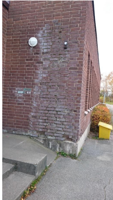
Figur 41. Utsidan på hemkunsken, väggen mot rum 111 Skolkök.
