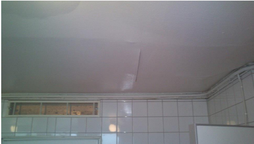
Figur 20. Hängande tak i herrarnas omklädningsrum.
