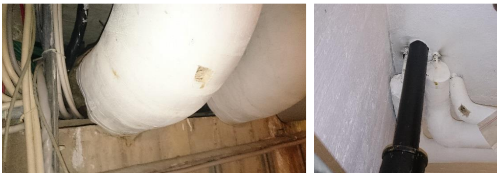
Figur 52. Rökrökar innehållande asbest i U. Centr 0.4 samt Frd 0.3 i källaren under Oppeby Idrott.
