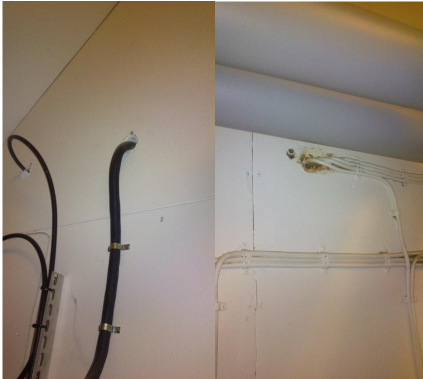
Figur 6. Brandtätning saknas.
