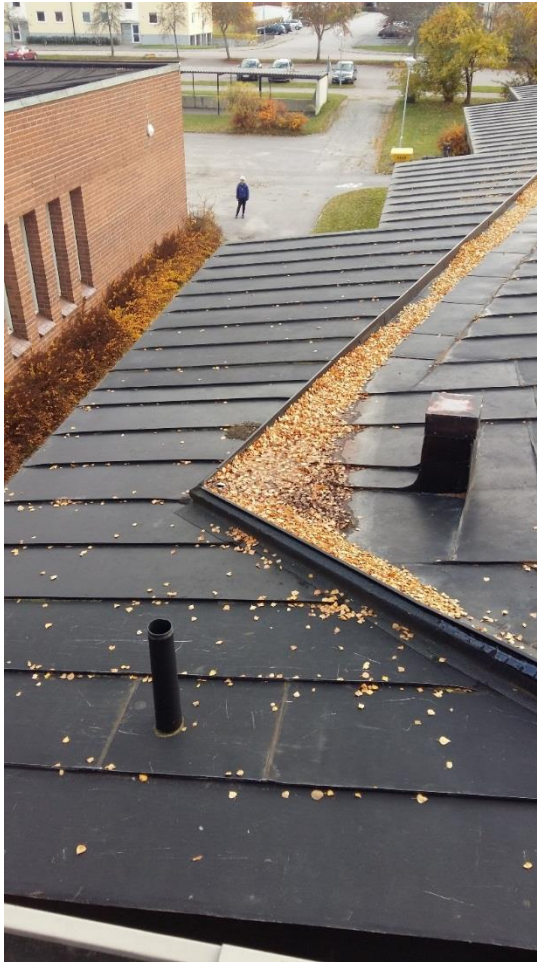
Figur 25. Igensatt regnvattenbrunn på taket.
