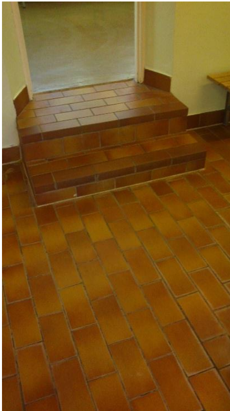
Figur 19. Trappa mellan omklädningsrum och duschrum i herrarnas omklädningsrum.
