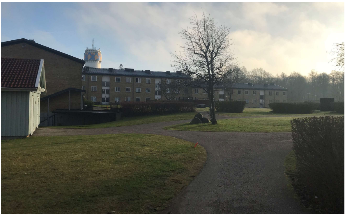
2. Vy mot lamellhusen som kantar kvarterets norra och östra sida, sett från innergården.
