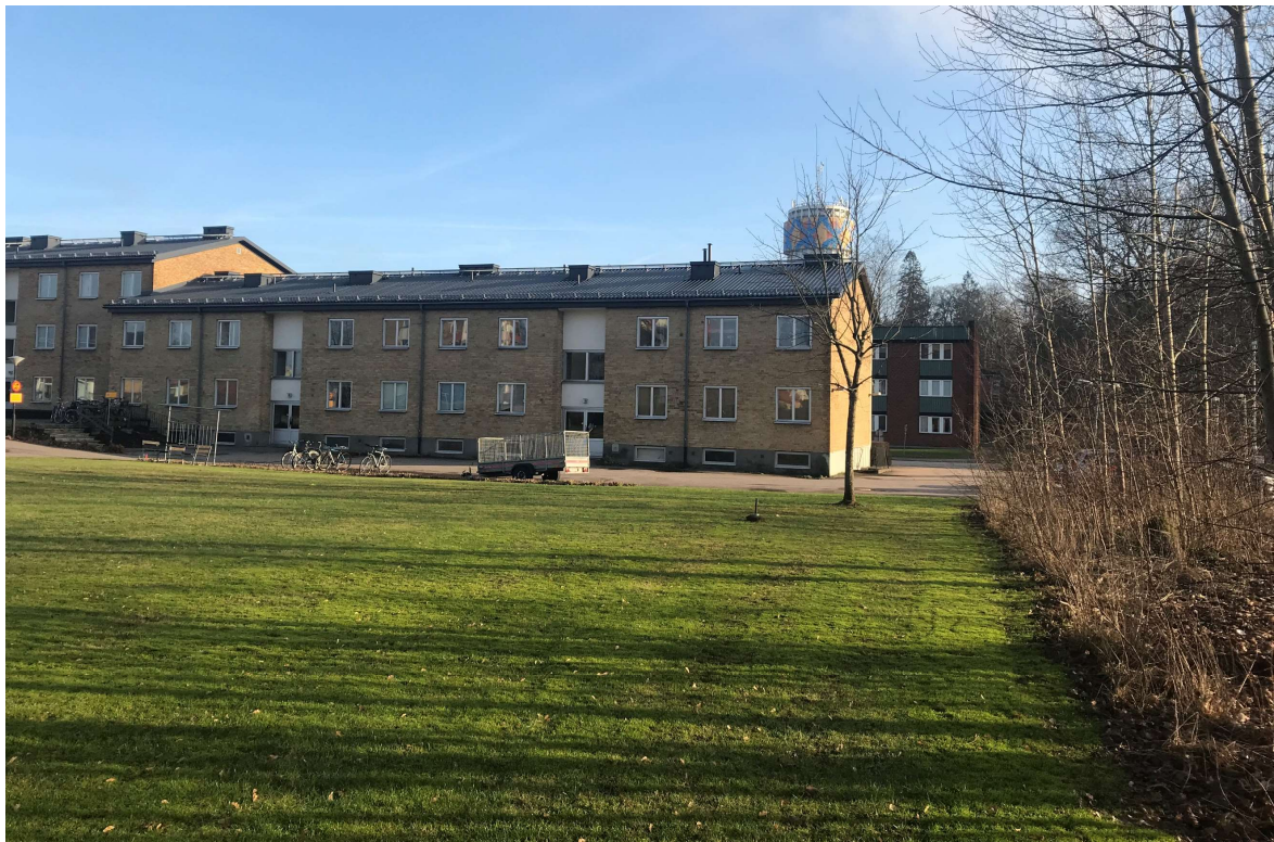
5. Lamellhusen som kantar kvarterets norra och östra del samt vy över en del av innergården.
