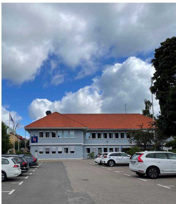
Figur 10: Kontorsbyggnaden i norra delen av planområdet.
