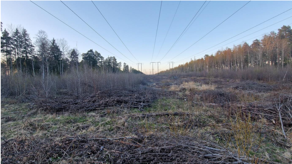
Bild 1. Kraftledningsgatan vid Lastpallen, Västerås.
