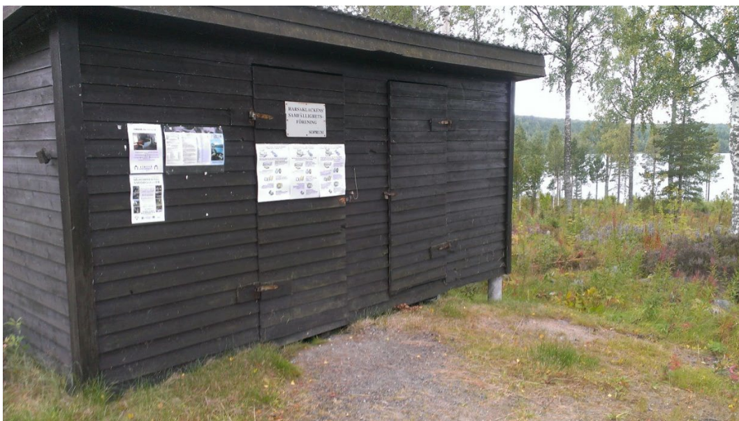
Befintlig återvinningsstation inom planområdet.
