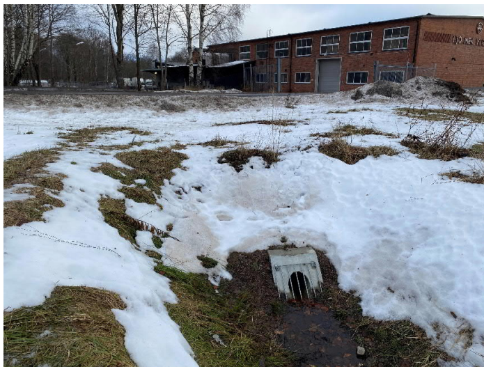
Figur 8. inlopp till dagvattenledning från delområde 1. I bakgrunden Strömsdalsvägen och Hjo mekaniska verkstad.
