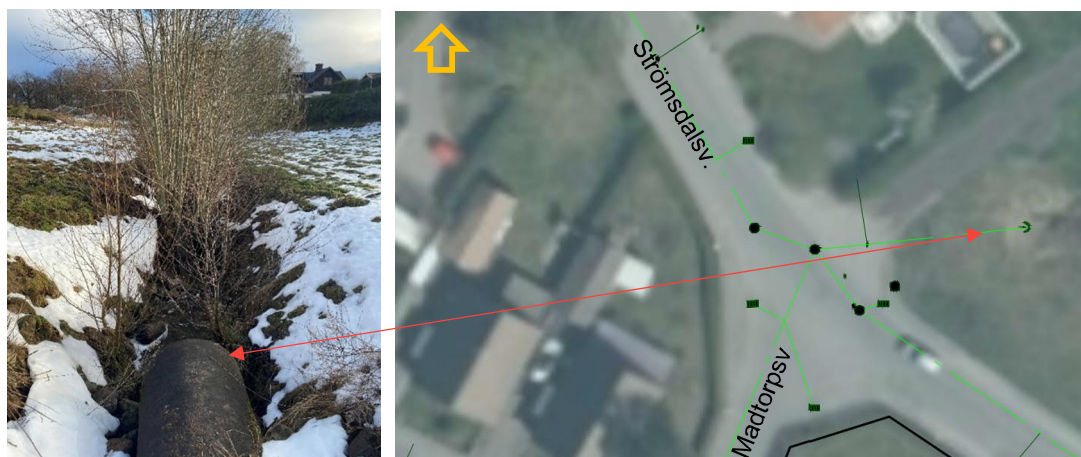
Figur 12. Utlopp från ledningsnät till dike vid Madtorpsvägen.
