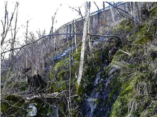
Bilderna visar brant berg i området där inga lösa block finns och ingen sprickbildning som bedöms vara farlig.
