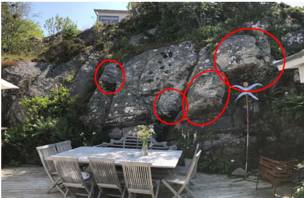
Bild 2: Potentiellt lösa block vid fastighet Evensås 1:13.
