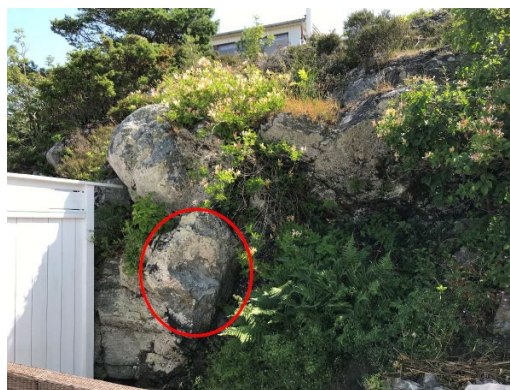
Bild 1: Potentiellt löst block vid Evensås 1:19.
