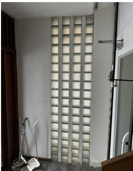
Till vänster. Väggarparti av glasbetong intill entrén.
