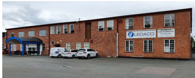
Vy från nordväst (norra fasaden).
