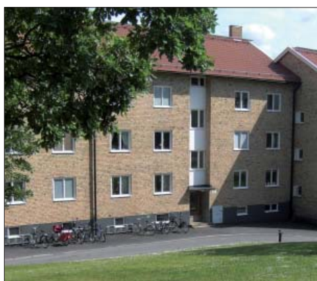
Befintlig bostadsbebyggelse, Kv Trappen
