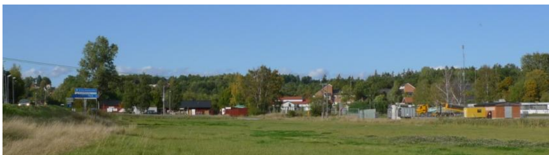
Vy från Munkhagen över västra delen av Hammarängen. Till vänster Stallarholmsvägen, därefter det före detta trädgårdsmästeriet, förskola i bakgrunden och till höger kraftstationen på Munkhagen.
