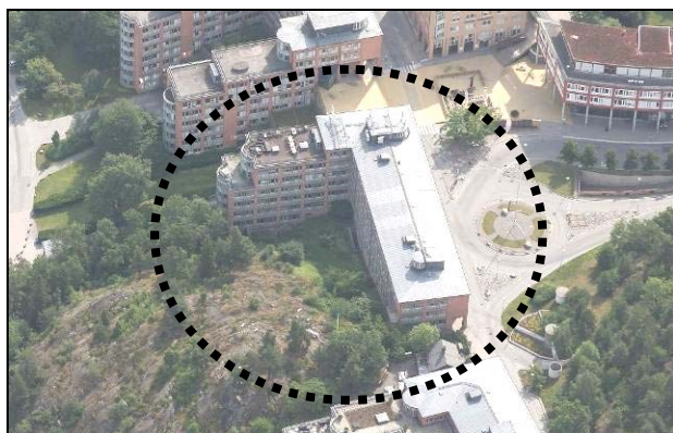
Befintlig kontorsbyggnad som föreslås ersättas
