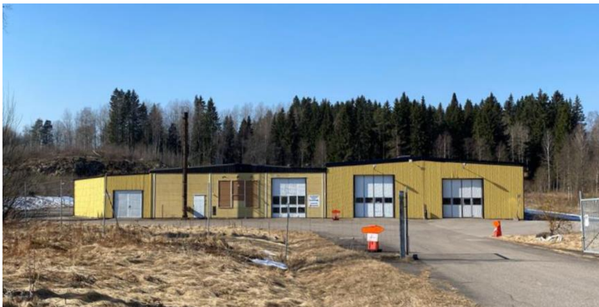
På bild: Huvudbyggnaden, Svarven 1. Fotot lånades från en fukt- och miljöinventering som utfördes i mars 2022.
