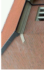
Takstodsdelar och plåtarbeten ska utföras med omsorg
