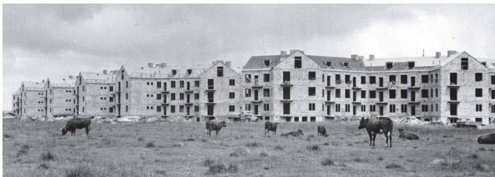
Rosta Stjärnhus under uppbyggnad.
